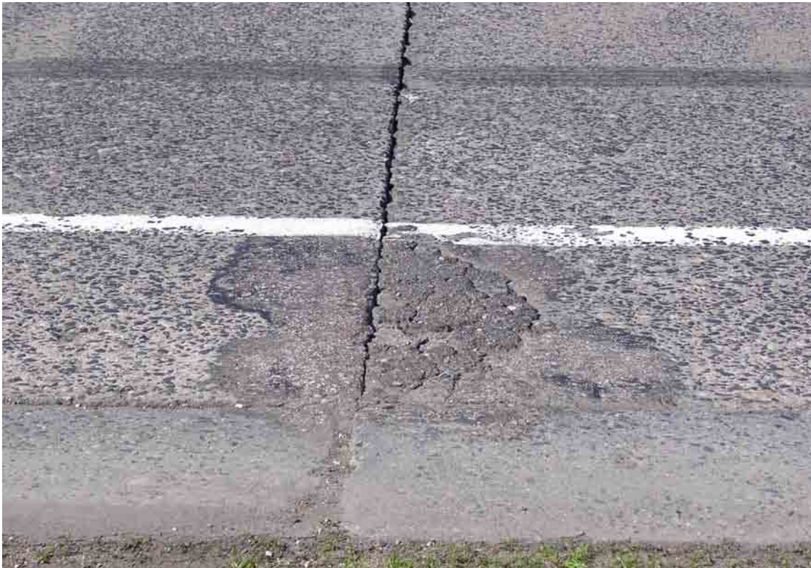
Fot. 49. Wykruszenia szczeliny bez luźnych fragmentów – szkodliwość mała (WS)
