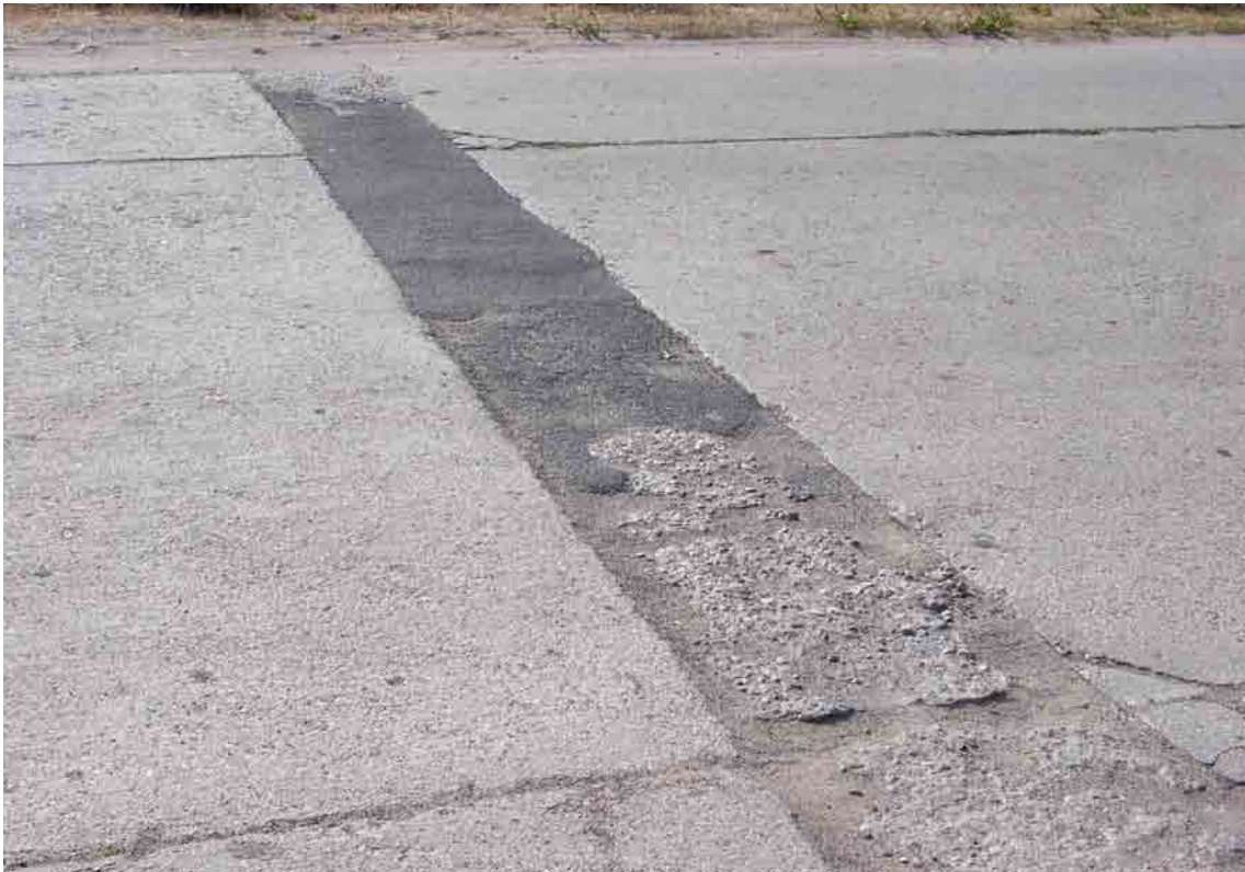
Fot. 67. Łata bitumiczna w celu naprawy uszkodzenia (LA)
