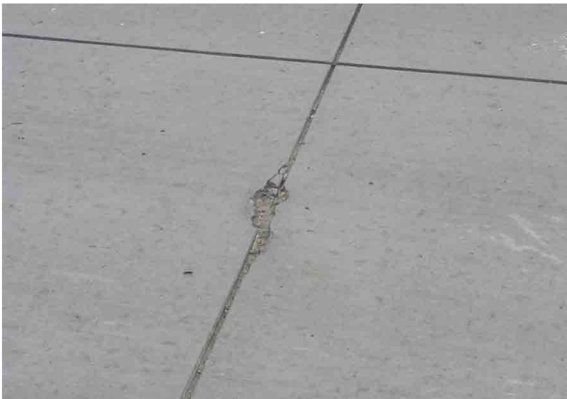
Fot. 50. Kolejny przykład wykruszenia szczeliny o małym stopniu szkodliwości (WS)
