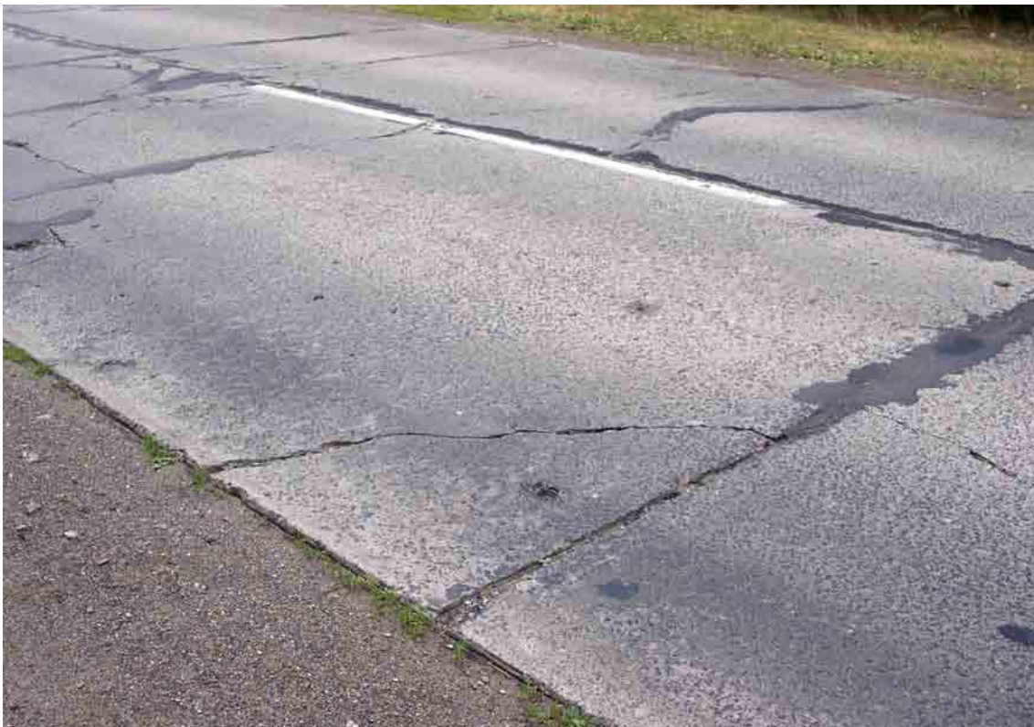
Fot. 42. Przypadek pęknięcia narożnika z pogranicza szkodliwości małej i dużej (UN)
