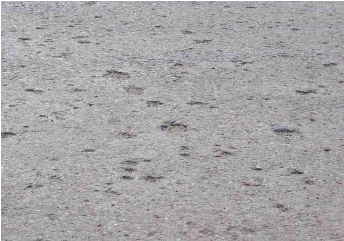
Fot. 58. Brakujące fragmenty materiału (UP)
