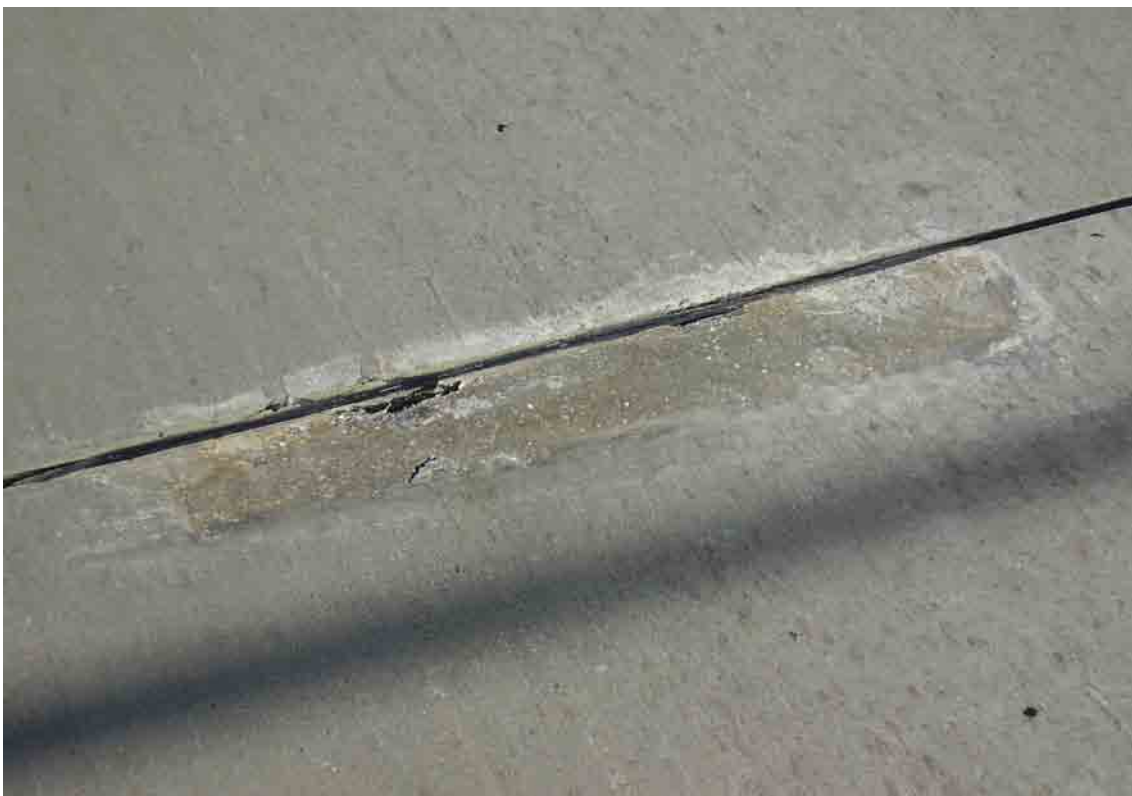
Fot. 48. Wykruszenia szczeliny o małym stopniu szkodliwości (WS)
